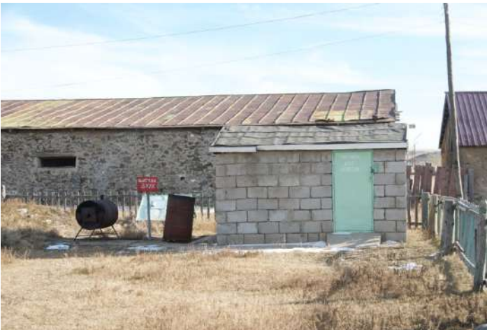
Эмнэлгийн хог хаягдал хадгалах талбай
