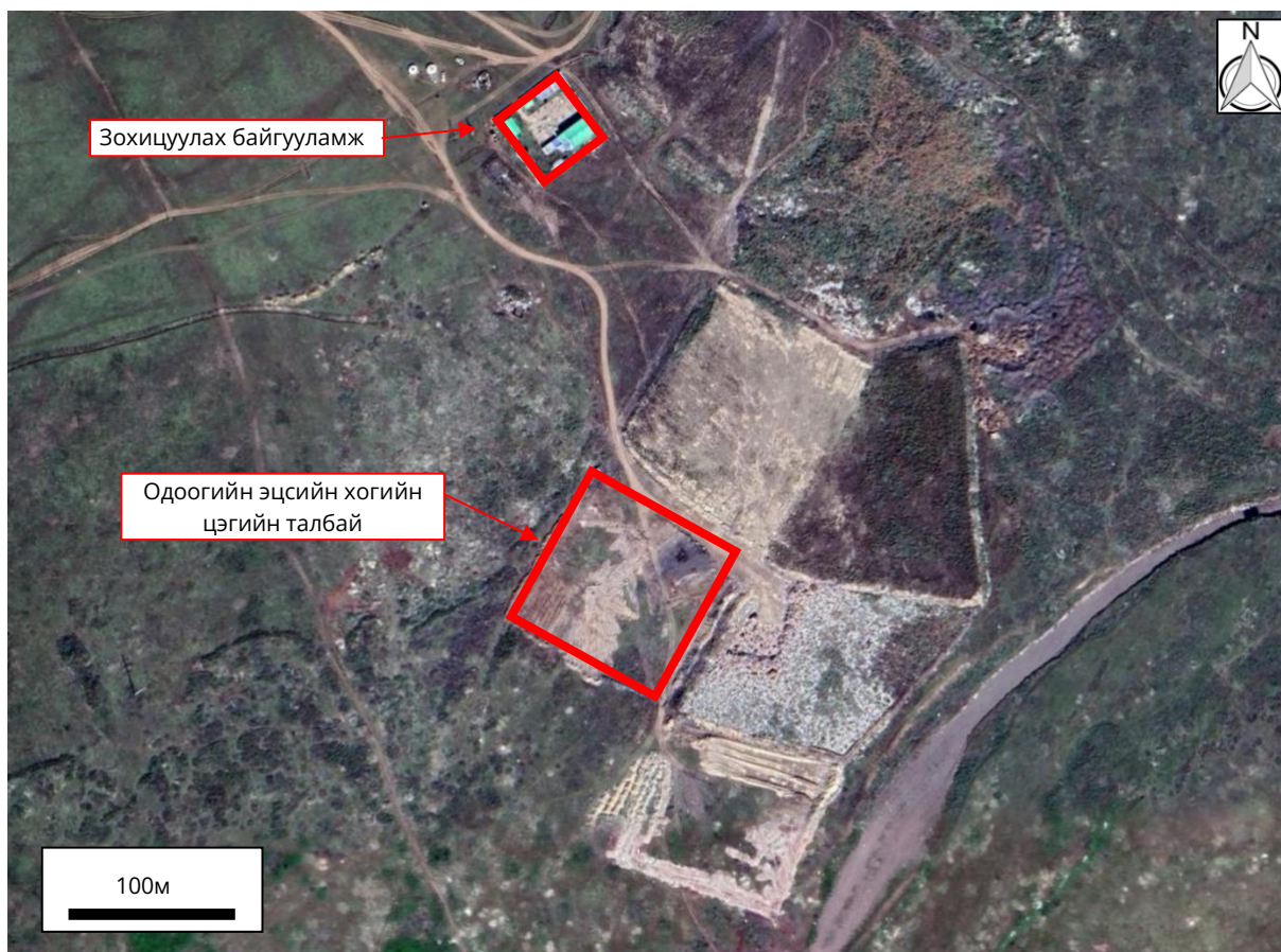
Газрын зураг №2: Булган сумын хог хаягдал зохицуулах байгууламж, одоогийн хогийн цэгийн байршил
